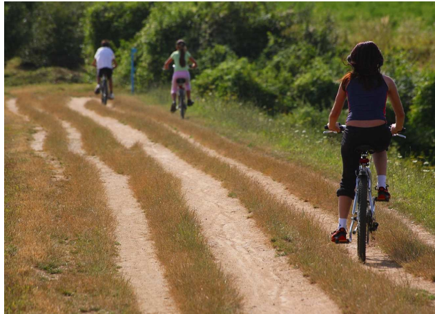
3.24. ábra: Árvédelmi töltésen vezetett kerékpárforgalmi nyomvonal burkolatlan felületen
