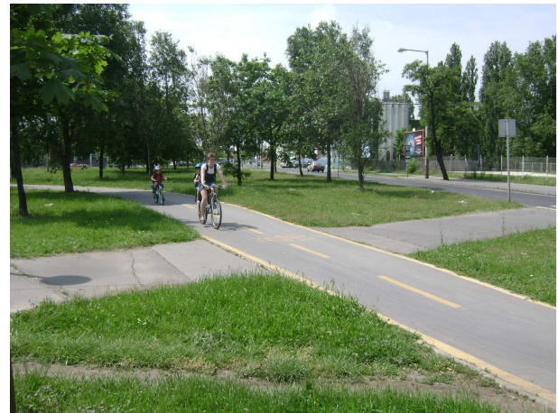
3.8. ábra: Önálló vonalvezetésű kétirányú kerékpárút
