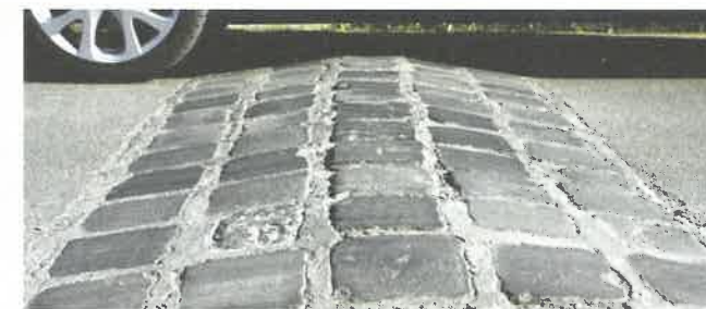
■ NEM AZ IGAZI... – Betonba ágyazott nagykokakó burkolat, ami túl azon, hogy költséges, beépítésekor az útpálya szerkezetét is meg kell bontani
