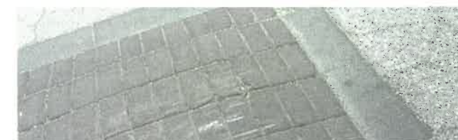
■ NEM MINDIG LÁTNI – A fotón egy térkő burkolat látható meredek felvezetéssel. Sötétben, vagy ha rosszak a látási viszonyok, késő észlelhetjük a „fekvőrendőrt”, így előfordulhat, hogy ráhajtáskor megsérül az autó alváza is
