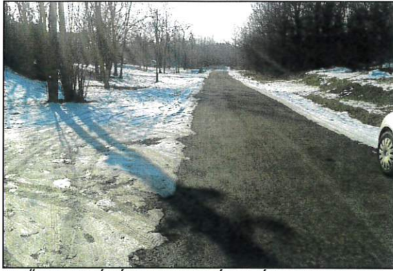
ELŐTTE KIÉPÍTETT SZILÁRD ÚTBURKOLAT
