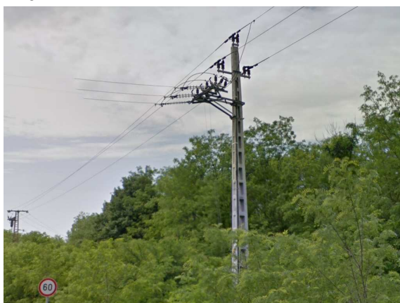
20 kV-os elosztóhálózati szabadvezeték és tartószerkezete
