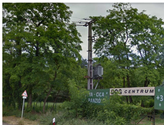
22/0,4 kV-os oszloptranzformátor és tartószerkezete
