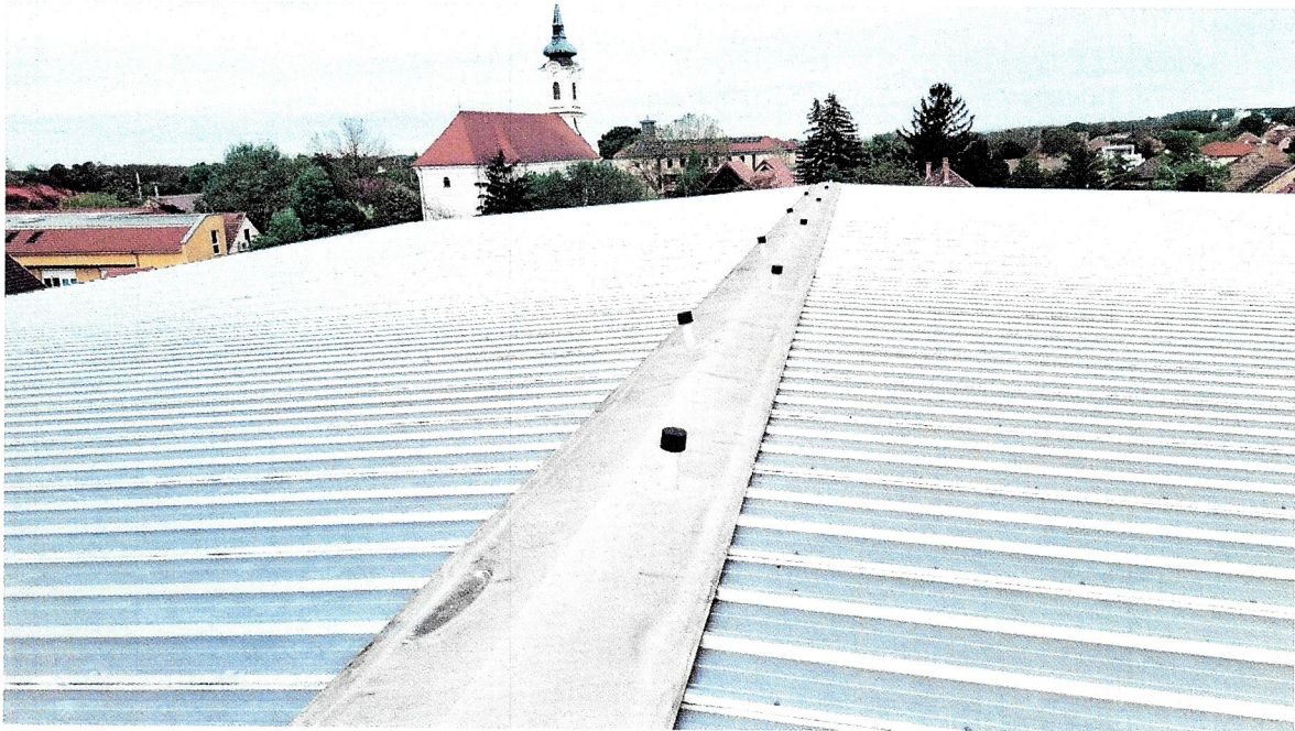
5. ábra Tetőszerkezet felülről
